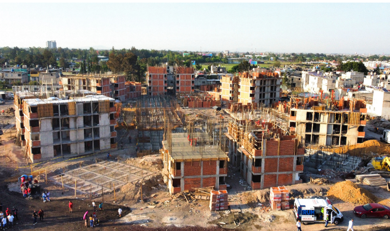
Proceso de construcción de vivienda en La Montada, Iztapalapa
