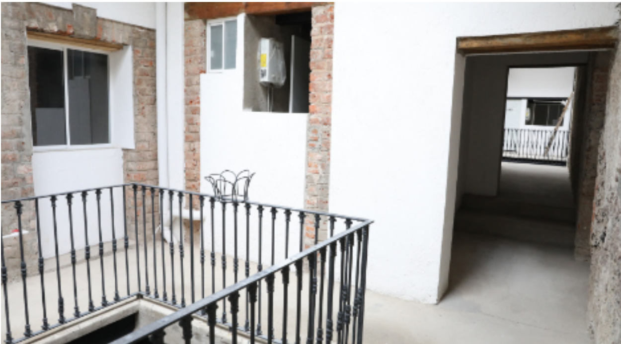
Programa Especial de Vivienda en el Centro Histórico inmueble Belisario Domínguez No. 78 (interior)
