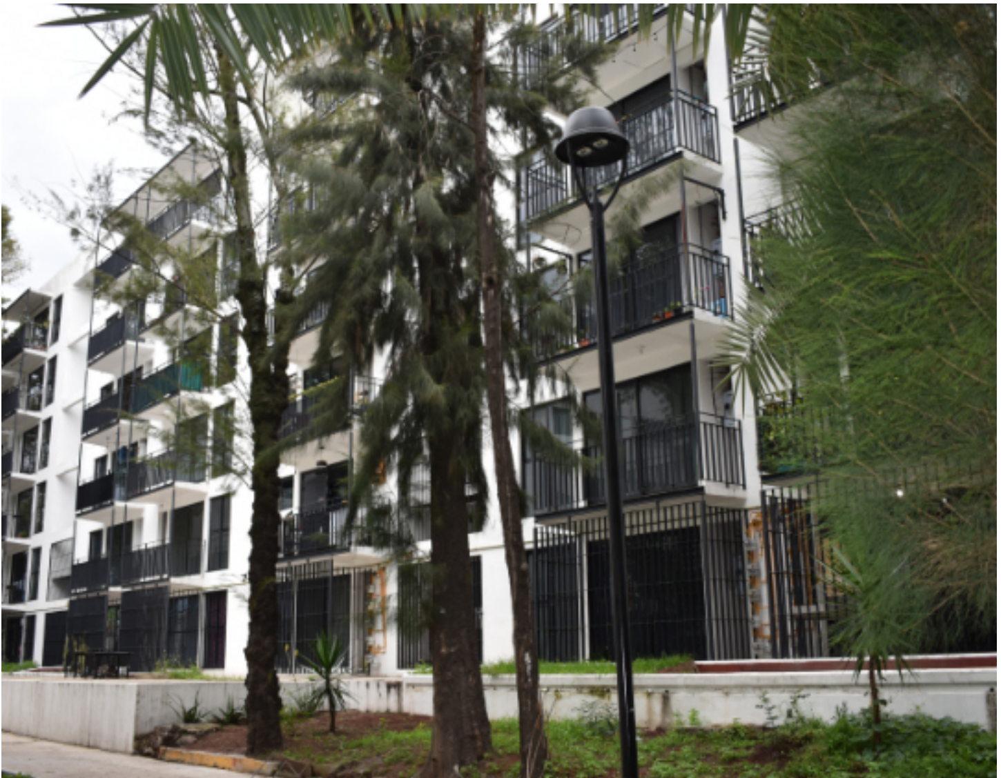
Revisión del proceso de reconstrucción y rehabilitación de los inmuebles afectados, Unidad Habitacional Tlalpan
