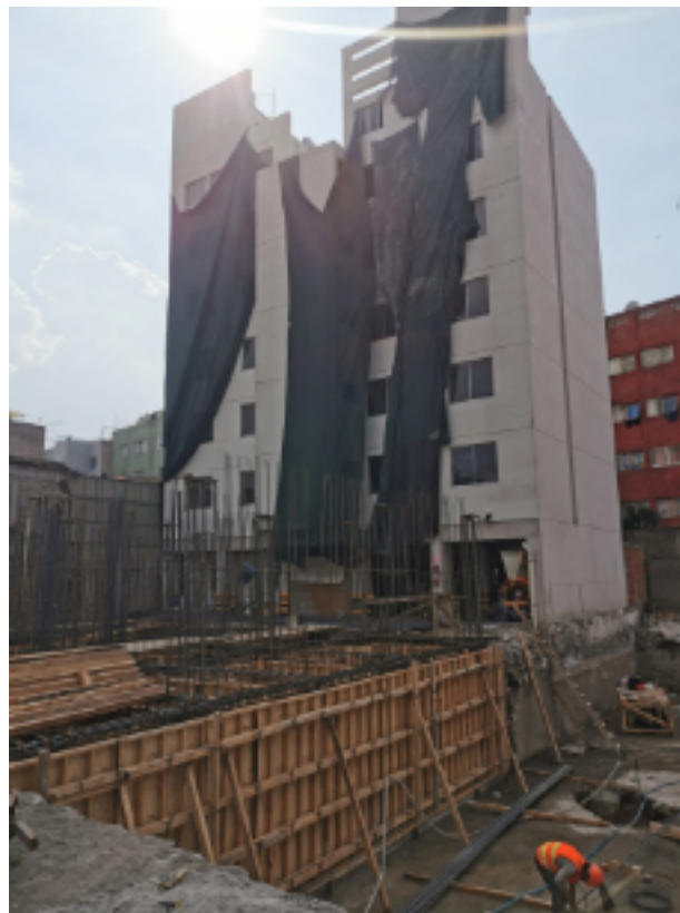
Como parte de la Reconstrucción y Rehabilitación de viviendas dañadas por el sismo 2017, se muestra el inmueble Galias No. 31
