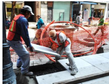
Obras de peatonalización
